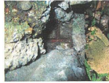
K62 : コンクリート杭
